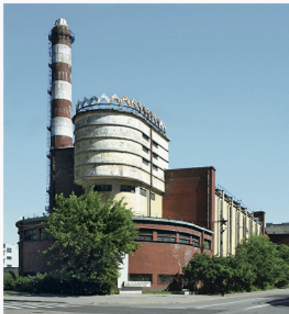
Э. Мендельзон. Силовая подстанция текстильной фабрики «Красное знамя» в Ленинграде (ныне С.-Петербург). 1925–26. Фото Д. В. Соловьёва
